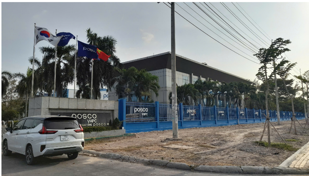
CÔNG TY CỔ PHẦN TRUNG TÂM GIA CÔNG POSCO VIỆT NAM - CHI NHÁNH ĐỒNG NAI - VHPC Địa chỉ công trình: Huyện Nhơn Trạch, Đồng Nai. Hạng mục: thi công lắp đặt hàng rào thép Giá Trị hợp đồng: 388.564.000 đồng
